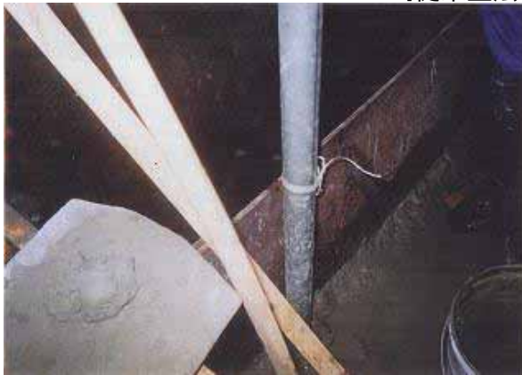
止水板設置状況：ベニヤ板を現場で加工
