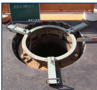
受枠をセットしたスパイダーを設置。必要に応じてアンカーボルトを設置します。
