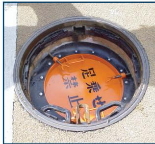
鉄蓋を取り外した後、ガラ落ち防止の遮断プレートを取付けます。
