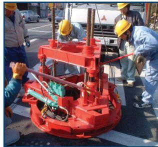
フレームリフターの油圧ジャッキを操作し、受枠を引上げます。
