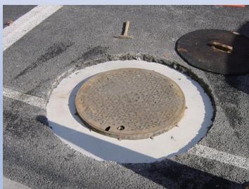
**LB工法専用に開発されたプレミックスモルタル。早強性、無収縮、高流動性、高強度の性能が、LB工法の構造基盤となります。**
