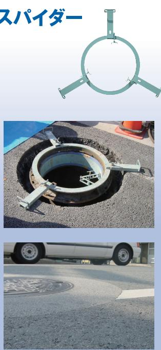
**受枠と周辺舗装の高さを揃える、定規の役割をします。**
