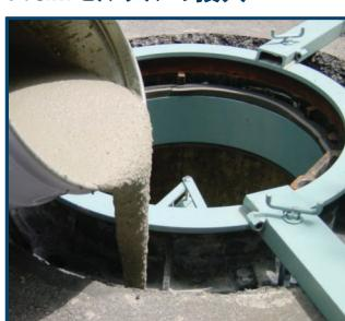
GMモルタルを混練りし、路面の高い方から流し込みます。
