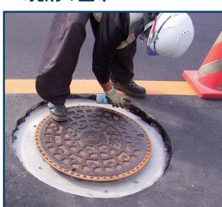
GMモルタルの硬化を確認し、乳剤を塗布します。
