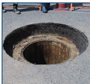
老朽化し弱くなった部分を撤去し、施工範囲内を修整・清掃します。
