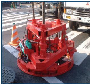
設置位置をマーキングし、その位置にフレームリフターを設置します。
