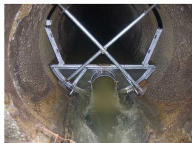
それ以上の流れがある場合、止水板設置前に、足場用の単管を×字状に組み、単管で止水板を支えながら設置すると、スムーズに設置できます。(単管は、転倒防止バーと重ならない位置に設置すること。)
