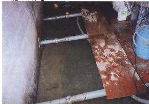
止水が完全でないため作業台を設置
