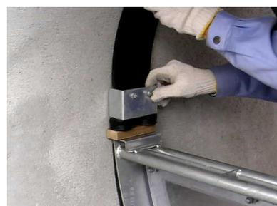
○固定バンドと転倒防止バー台座の締め込みは、固定バンド側を優先的に締め込んでください。転倒防止バーの台座を締め込み過ぎると、止水板が浮いて漏水の原因となります。
